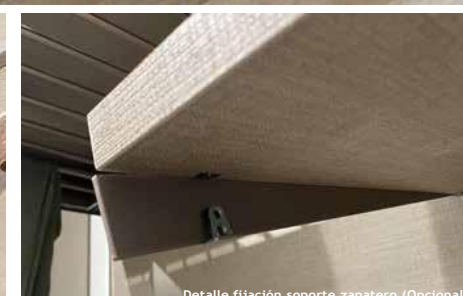
Detalle fijación soporte zapatero (Opcional)
