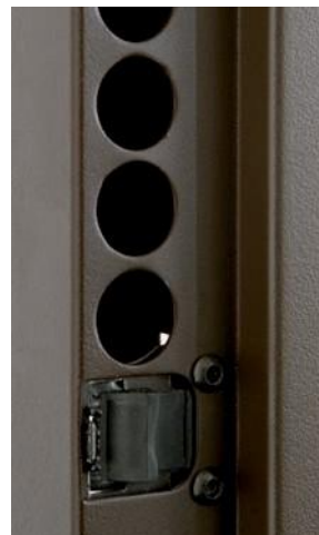
Sistema antitarjeta y regulación del resbalón
